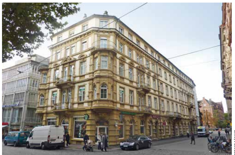
► Der Freiburger Hof vor der Dachaufstockung. Bis dato schloss ein Notdach das Gebäude ab
